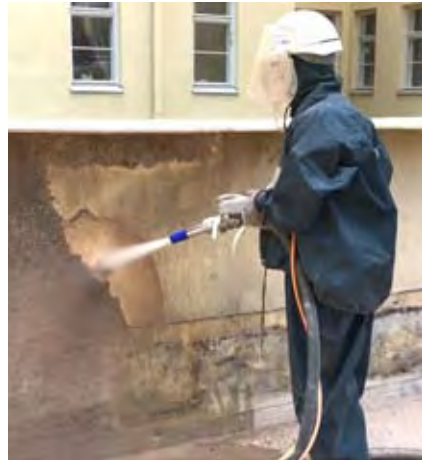
Pölytöntä ja tehokasta pinnoitteenpoistoa tukimuurista.
