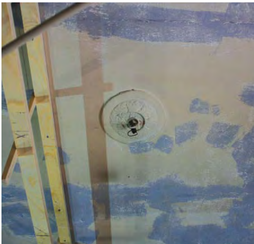
Kruununhaassa sijaitsevalla työmaalla katon alkuperäinen rosetti paljastui, kun levykatto purettiin. Tilan huonekorkeus lisääntyi samalla 30 senttiä.
