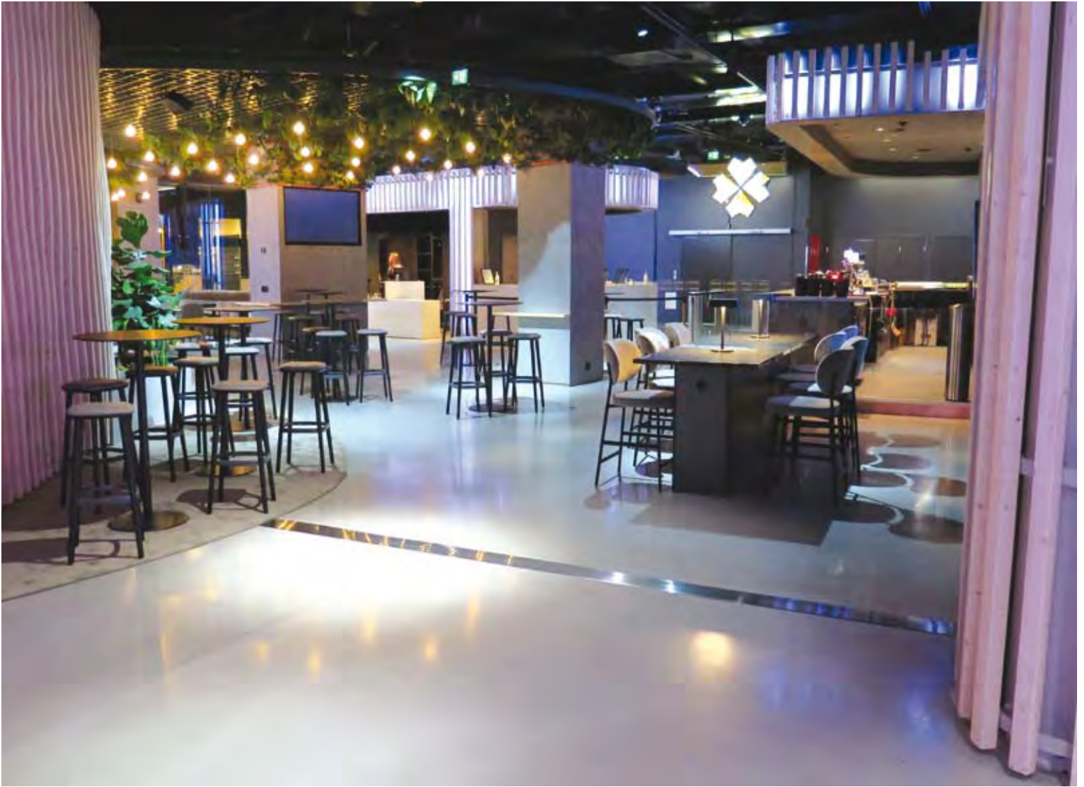
BCSA-sementtiin pohjautuva TRU PC arkkitehtoninen pinnote sopii kovan kulutuksen kohteisiin, kuten erilaiset aula- ja muut yleiset tilat. Kuvassa vuoden parhaaksi uudeksi casinoksi maailmassa valittu Tampereen Casino.
