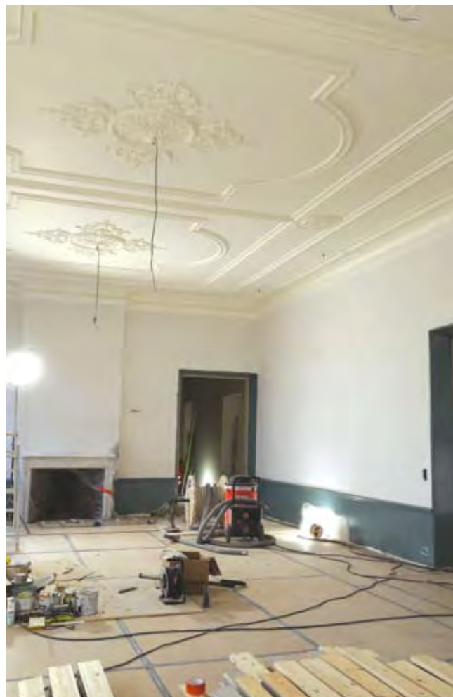
Salonki juuri valmistuneine kattokoristeineen. Seinät odottamassa alapaneelien koristemaalauksia ja yläosan Chinoiserie tapetteja.
