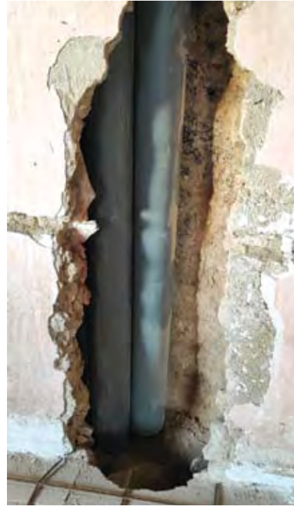
Uutta viemäriverkkoa varten saviseinään on tehty aukkoja.
