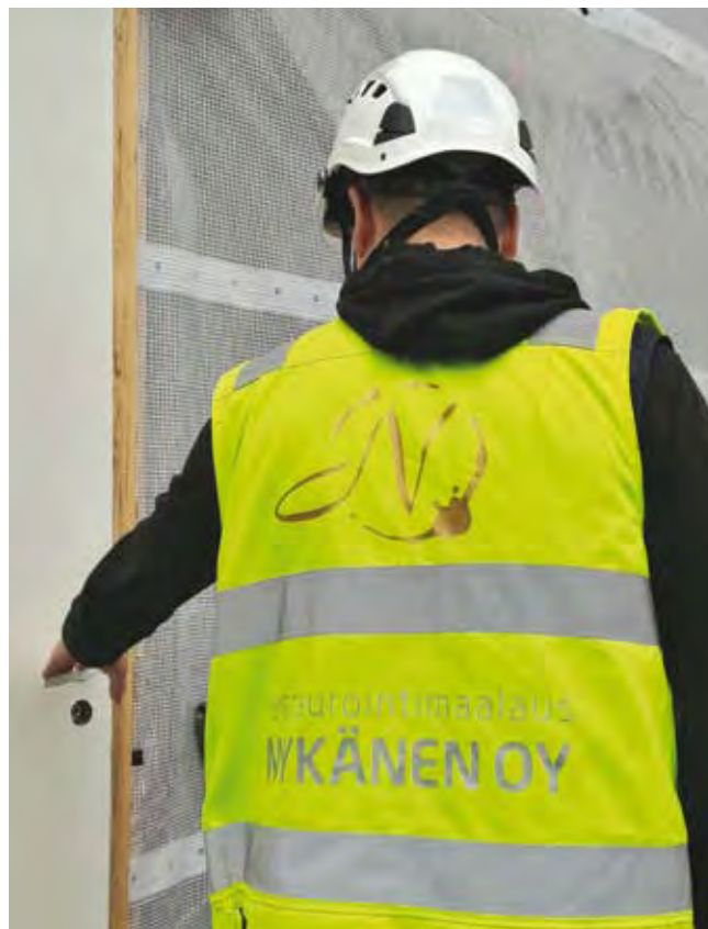
Toni Nykänen menossa työmaalle sääsuojien läpi, ovien taakse kätkeytyy erilainen arvohuoneisto upeine sisätiloineen.
