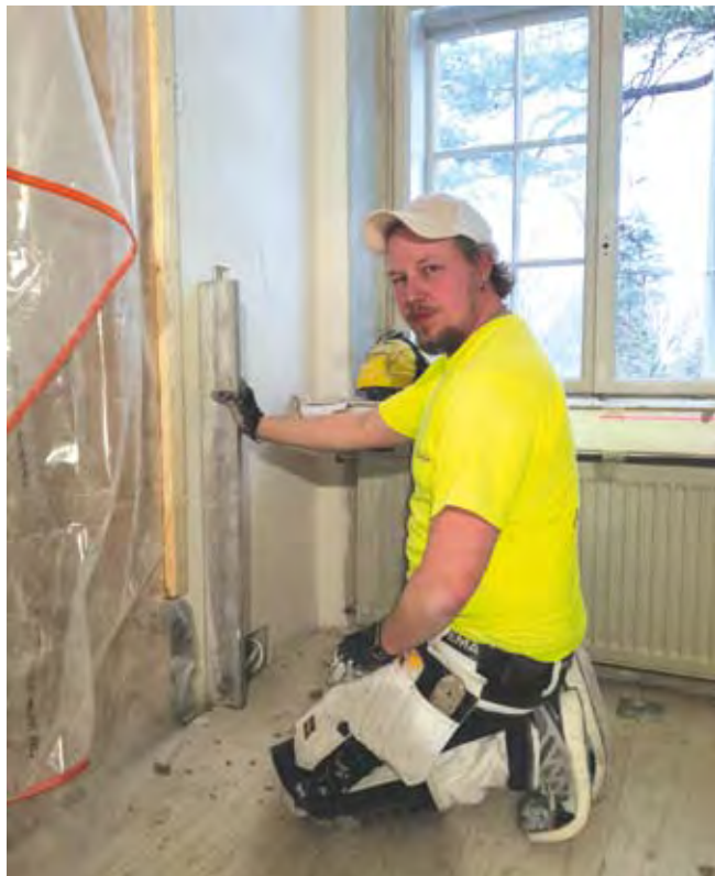
Huoneiden jakolistojen pohjat ja tapetointi vaatii suorat pohjat, Jani Tikka oikaisujen laatua tarkastamassa.
