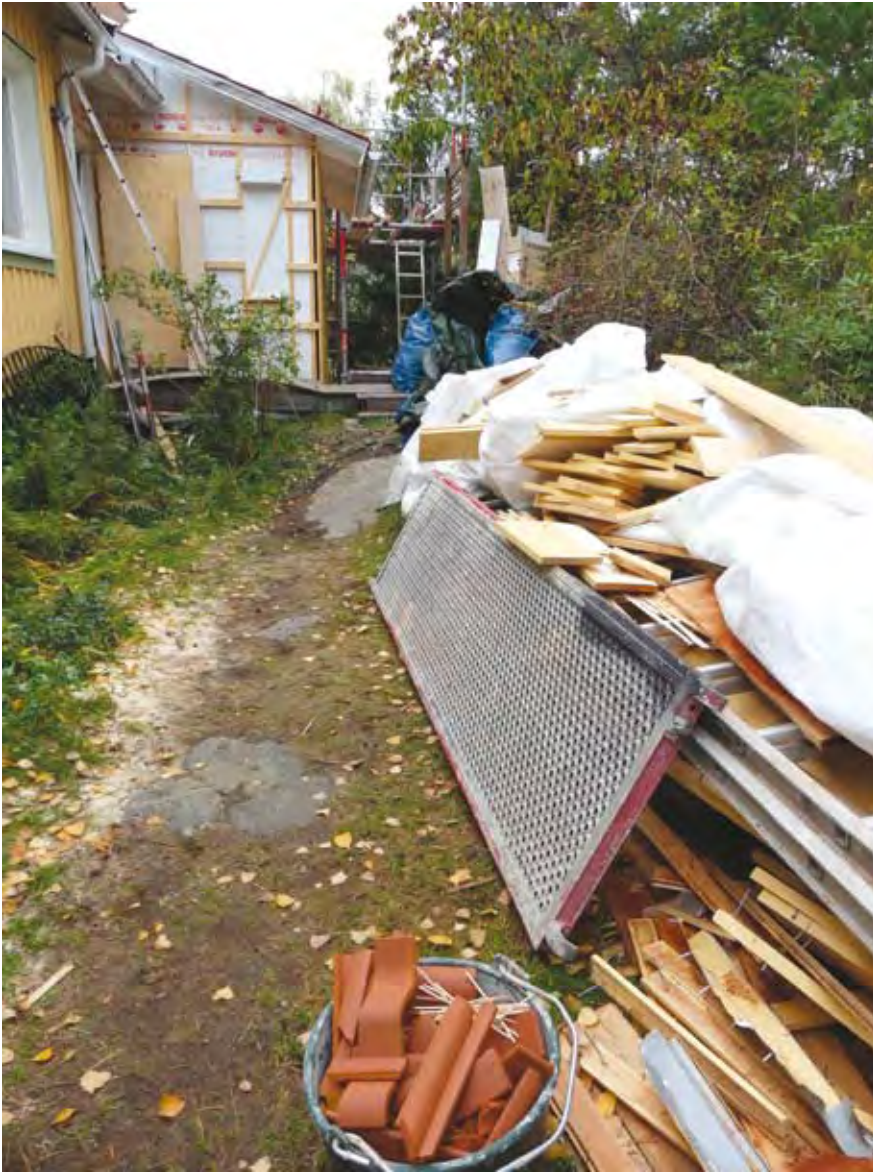
Lisärakennus nousee Nackassa.
