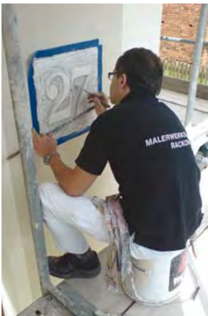
Kestävä korjaaminen on pääosin käsityövaltaista. Kuvassa Manuel Rackow.
