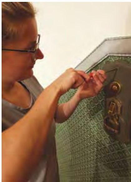
Muodon ja tilan vaikutus, yksityiskohtat, eri värit. Maalarimestari Marlene Rackow viimeistelee berliiniläisen Jugendvillan portaikon yksityiskohtia. Kuva Manuel Rackow
