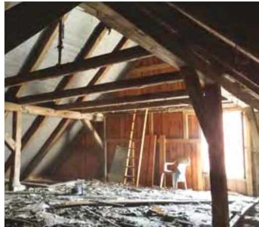
Edingerien talo oli niin huonossa kunnossa, että se piti purkaa lähes kokonaan. Rappauksen alta paljastui mädäntynyt puukehikko ja vanhentuneet tiilet. Kun kivijalka oli uusittu, kirvesmies Wulff rakensi uuden kehikon ja uudet tiilet muurattiin kehikkoon. Kuvat Hans Richard
