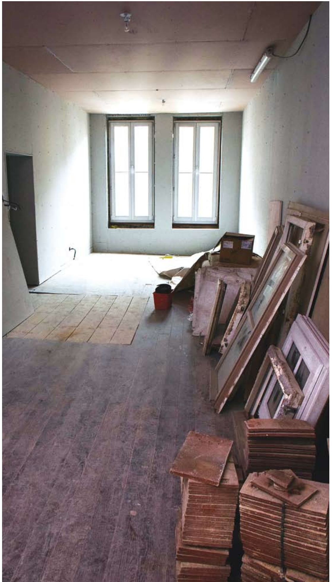
Troyes'n keskustan vanhat talot ovat usein ankeassa kunnossa. Kaikki lattiaita, seiniä, kattoja ja rappusia myöten on pistettävä uusiksi. Tietysti myös sähköt, putkistot ja muut on saatava normien mukaisiksi.
