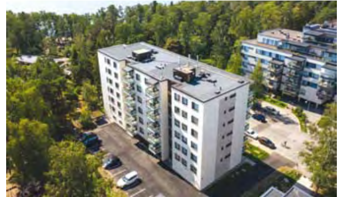
Asunto Oy Puistonportti Bostads Ab (Helsingin Lauttasaarella) on tuomariston mielestä onnistunut ja rohkaiseva esimerkki siitä, miten 70-luvun arkkitehtuuria voidaan uudistaa voimakkaasti ja rakennuksen ilmettä modernisoida rakennuksen alkuperäiset erityispiirteet kuitenkin huomioiden. Korjaushanke on kokonaisuudessaan harkittu, elinkaariajattelun ja pitkäaikaiskestävyyden huomioiva, perusteellisesti suunniteltu ja onnistuneesti toteutettu.
