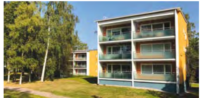
As Oy Viisikon (Espoon Tapiolassa) julkisivuremonttissa ansiokasta tuomariston mielestä oli erityisesti osakkaiden huomioonottaminen hankesuunnittelu- ja toteutus suunnitteluvaiheen aikana. Vuorovaihteisen suunnitteluprosessin erityispiirteenä oli mm. se, että osakkaat saivat asuntokohtaisten rahoitusvastikkeiden tasolle vietyä kustannustietoa. Hankkeessa hyödynnettiin ansiokkaasti myös nykyaikaisia työvälineitä asioiden havainnollistamiseksi ja visualisoimiseksi osakkaiden päätöksenteon tukena.
