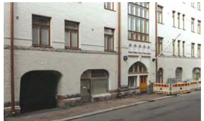
As Oy Kristian 17 (Helsingin Kruunuhaka) on tuomariston mielestä erittäin onnistunut esimerkki jugendajan arkkitehtuuria kunnioittavasta ja vaalivasta kulttuuriperintötyöstä. Vuonna 1906 valmistuneen talon julkisivuremontti on edellyttänyt perusteellista rakennushistoriallista selvitystyötä ja huolellista ja ammattitaitoista suunnittelua.
