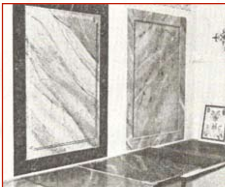
Seinäpinalle tehty kivenmukailu, joka on jaettu eri pinnoiksi viivoituksella.
