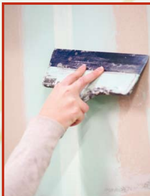
Timo Haapolahti oheistaa Jenna Liikalaa seinän tasoittamisessa.
