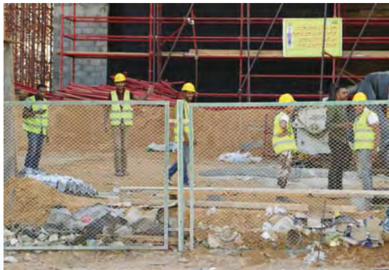
Uuden hallintopääkaupungin rakennustyömailla työskenteleviä tulee eri puolilta Egyptiä. Turvamääräysten toteutuminen on maan tapaan hieman vaihtelevaa.
