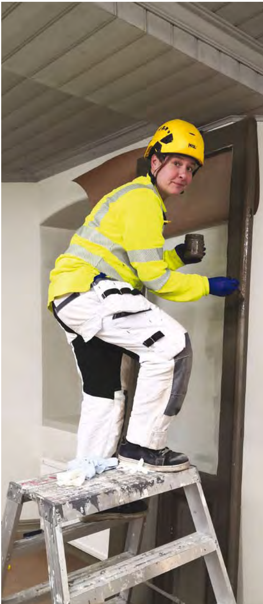
Anu Aholan työn alla neljä ovea - ja tietenkin keskenään erilaisia. Tässä vaiheessa pigmentti hierotaan tasaisemmaksi.
