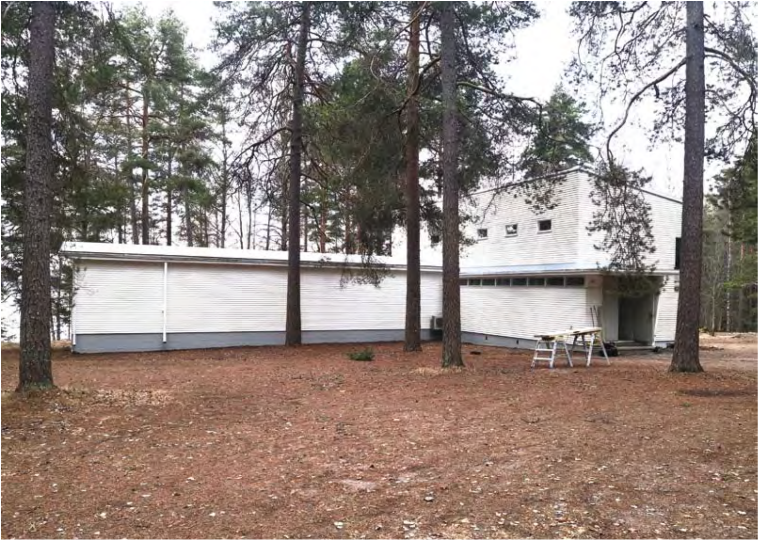
Arkkitehti Hugo Harmian 1939 suunnittelema alueen päärakennus Kasino oli ehtinyt jo aika vaatimattomaan kuntoon ennen korjausta.
