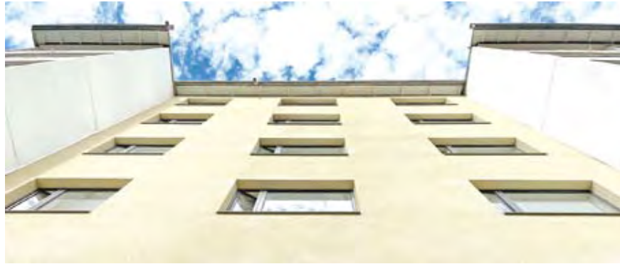
StoRenolla korjattu kerrostalo, Kuohurinne 4, Vantaa.
