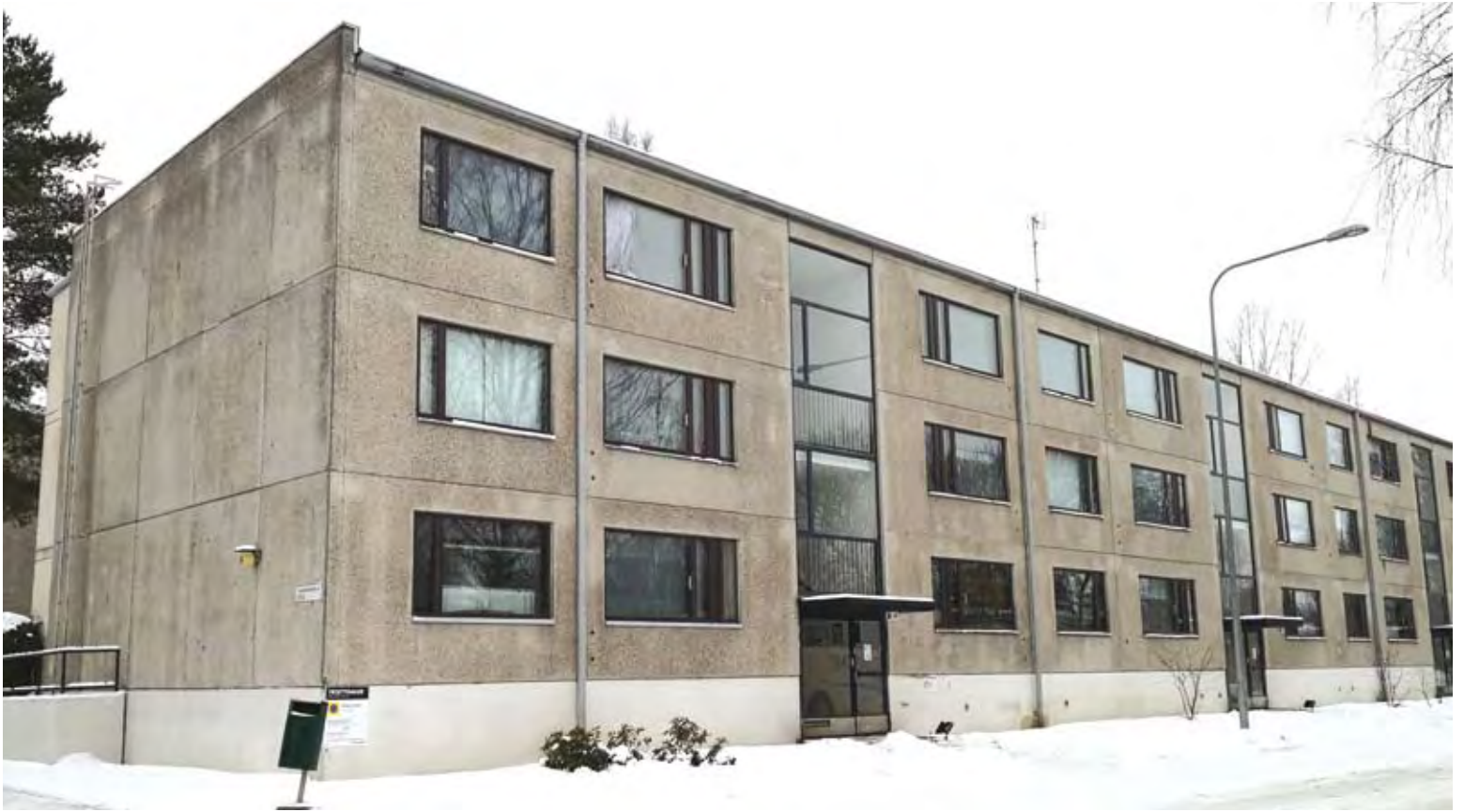
Helsingin Siltämäki. Käyttökänsä päässä olevat pesubetonipintaiset elementtitalot kuvaavat viranomaisen mielestä ajalle ominaista rakennuskantaa eikä niitä saa omistajan toiveesta huolimatta purkaa.
